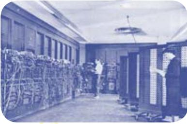
**1946** \_ ENIAC a été construit par John Mauchly et J. Presper Eckert. **En raison de sa technologie électronique, par opposition à électromécanique, il est plus de 1 000 fois plus rapide que n'importe quel ordinateur précédent.** ENIAC occupait plus de 1 000 m<sup>2</sup>, utilisait environ 18 000 tubes à vide et pesait 30 tonnes...
