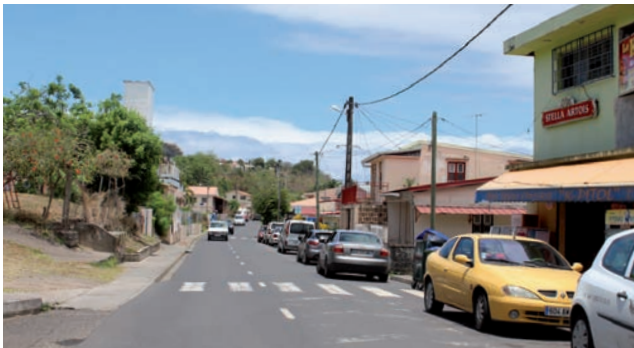
LA TRAVERSÉE URBAINE DEPUIS LA ROUTE DÉPARTEMENTALE AVEC LA VÉGÉTATION DES COTEAUX EN TOILE DE FOND
