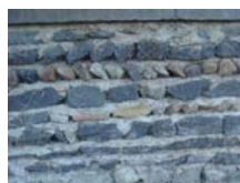
▲ Exemple de mur en moellon d'andésite
