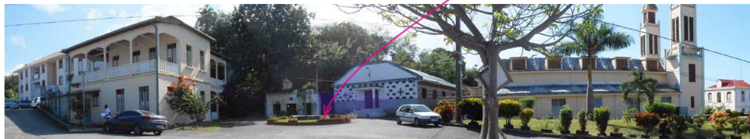
SITE DU PRESBYTÈRE À RÉHABILITER
