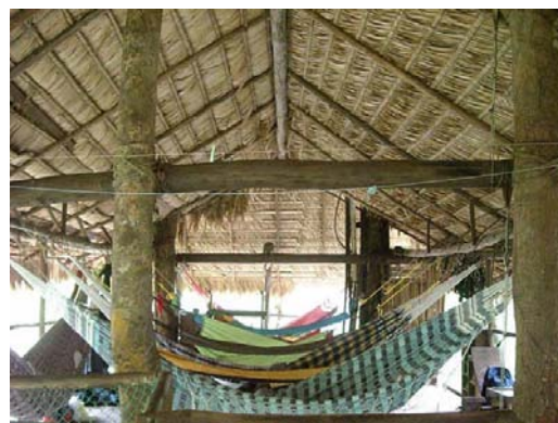
▲ Type de carbet en structure bois et couverture végétale (rondins bruts et chaumes de fibres végétales)
